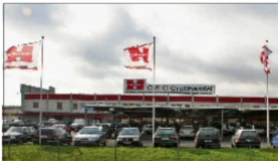
Voraussichtlich im Sommer erfolgt die nächste Umbaumaßnahme: Die Parkplatzfläche wird neu strukturiert und gestaltet.
